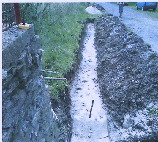
Oprava svodu dešťové vody v obci Dolní Jamné
