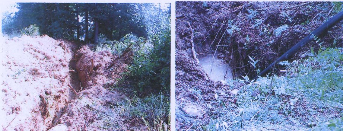
Oprava vody v Bučí.
